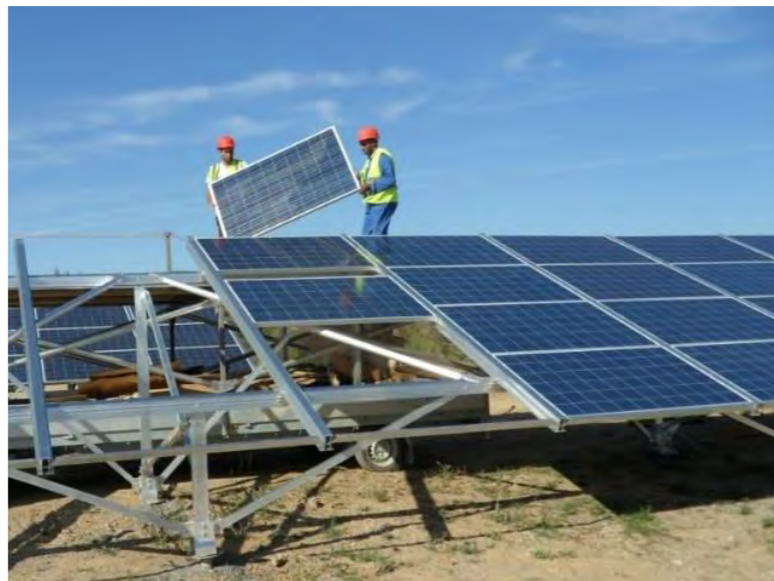
Figure 32 : Exemple de mise en place des panneaux sur les structures (Source : RES)
