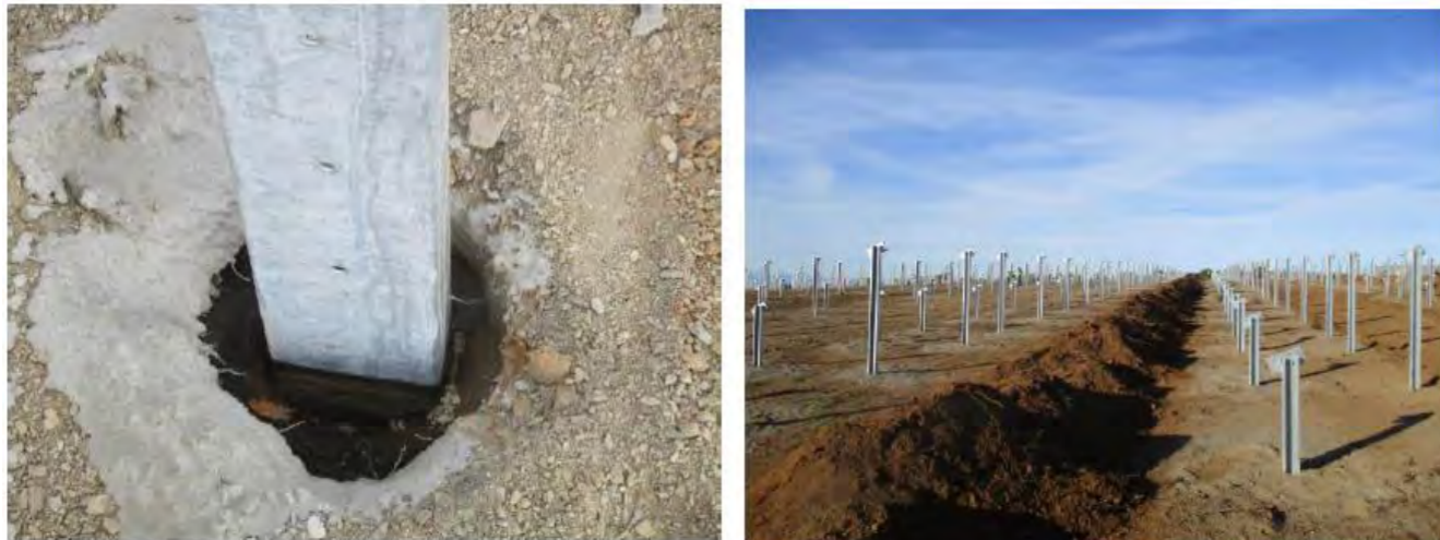
Exemple de fondation type pieux
