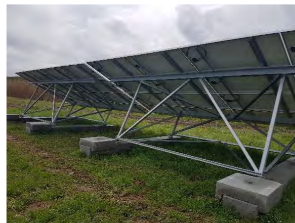
Figure 23 : Exemple de fondations béton (Source : RES)
