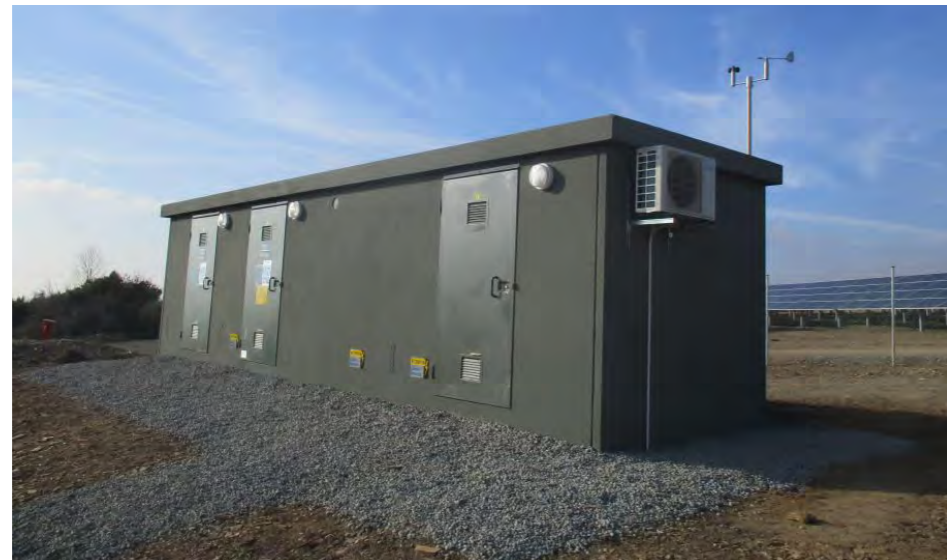
Figure 27 : Exemple de structure de livraison (Source : RES)
