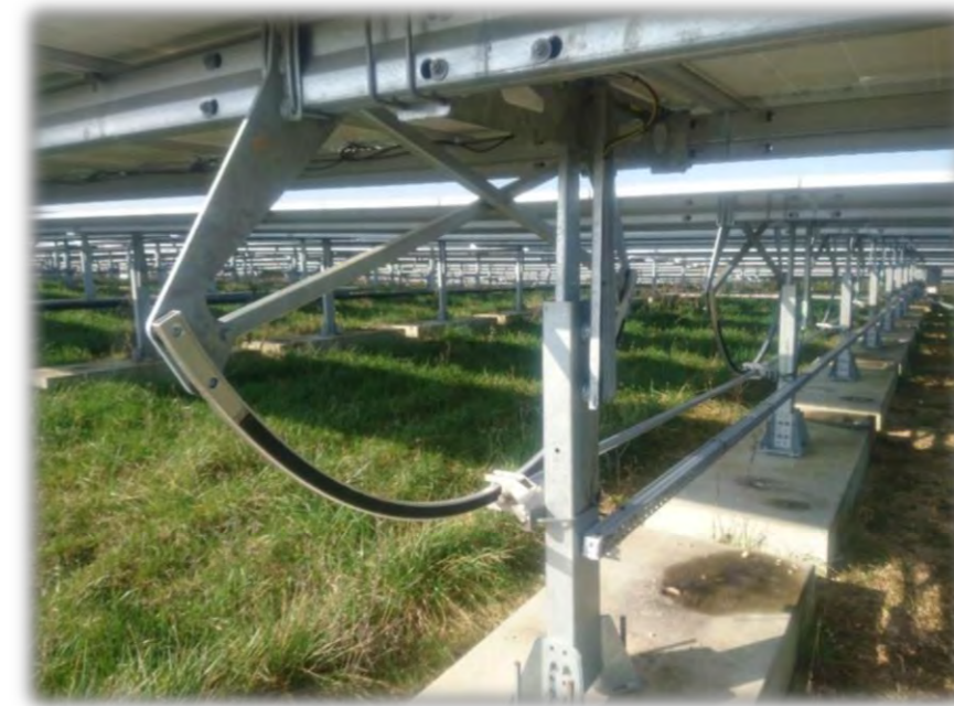
Figure 19 : Photo de trackers à rotation mono-axiale (Source : NCA environnement)
