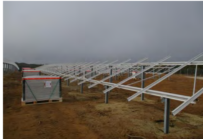
Figure 31 : Assemblage des structures sur site (Source : RES)
